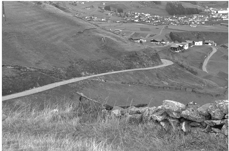
... und nach dem Bau der Meliorationsstrasse. Abb. 3 (Heg, 17. 10. 1990)
