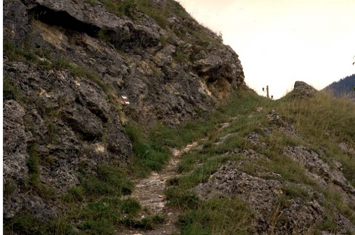
In den Fels geschrotete Passage des Saumweges GR 77.1.5. Abb. 1 (Heg, 17. 8. 1986)
